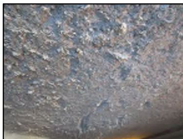
Photo N° 663 ECH-N°1 FLOCAGE -- LOCAL POUBELLE Plafonds Blanc cotonneux
